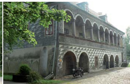
Miroslav Falta, ČESKOLIPSKÁ TEPLÁRENSKÁ a.s. Červený dům v Č. Lípě
