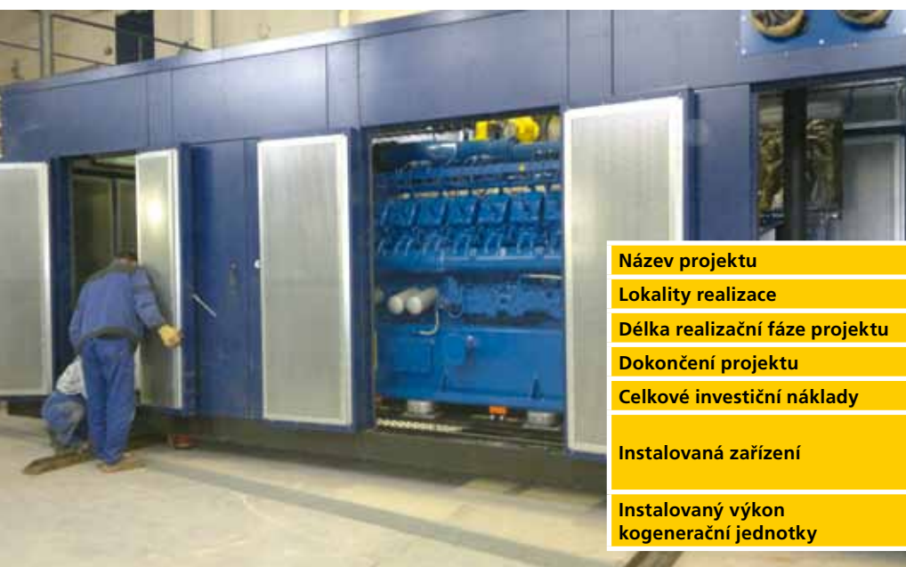
Celkový pohled do nově zrekonstruované kotelny na sídlišti Františkov (nahofe) a nová kogenerační jednotka v protihlukovém rámu (vlevo).
